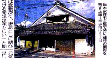
岸本家住宅主屋で特設時の面影を残す正面。幸手中で21日、自 岸本家住宅主屋 土蔵造り2階建て一部木造平屋、瓦ぶき。建築面積129平方m。江戸末期の建築と推定される。旧日光街道に面して建ち、大正時代までしょうゆ醸造業を営んだ旧家。屋根の構造が特徴的で正面の切り妻造りに対し、背面が寄せ棟造りとなっている。
